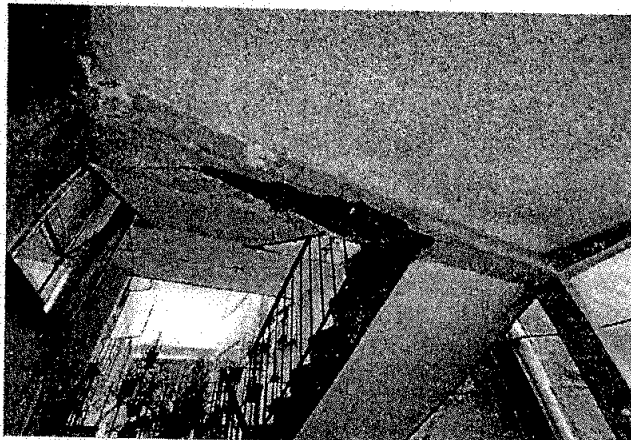
Imágenes 11 y 12. Acero expuesto en trabe de marco de concreto; Contraventeo de concreto armado, se puede observar fisuras en la parte inferior.
