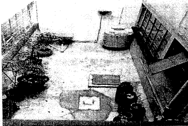
Imágenes 13 y 14. Vista del patio derecho, se observan 4 cilindros de gas los cuales no se encuentran sujetos al muro o piso; Tablero de instalación eléctrica.
