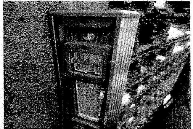
Imágenes 3 y 4. Deterioro de celosía; Desplome de elemento de confinamiento.
